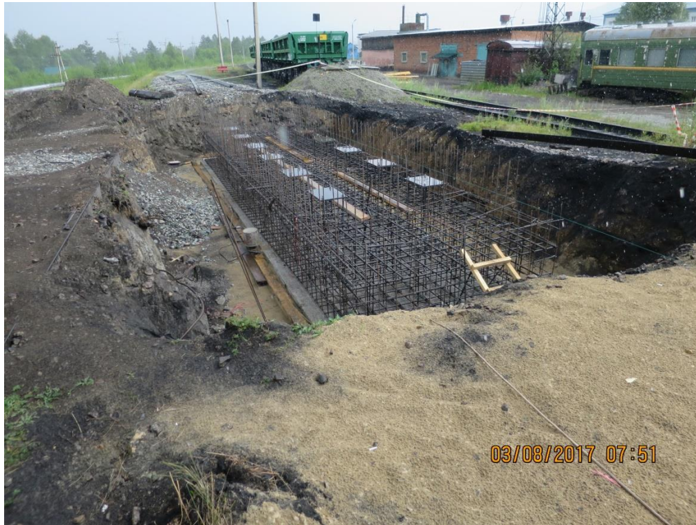
Подготовка фундамента вагонных весов
